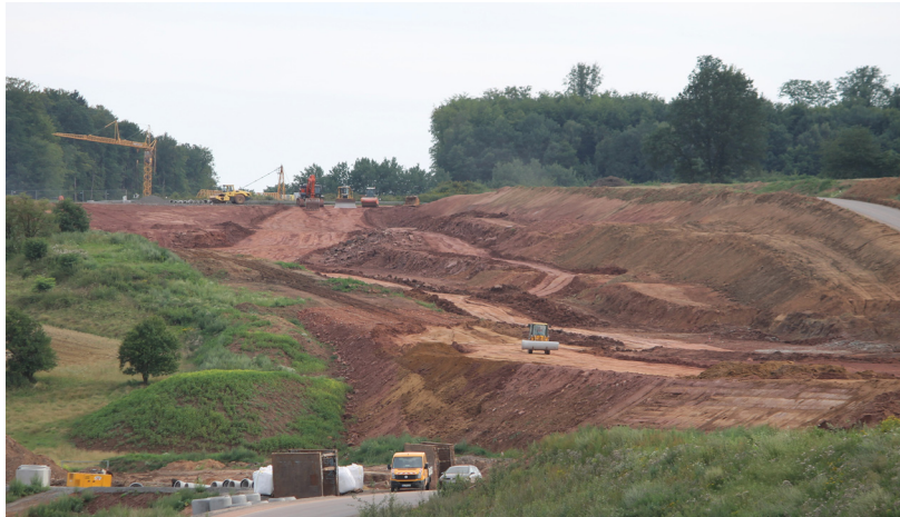
A49 Baustelle Schlierbach / Lanzke
